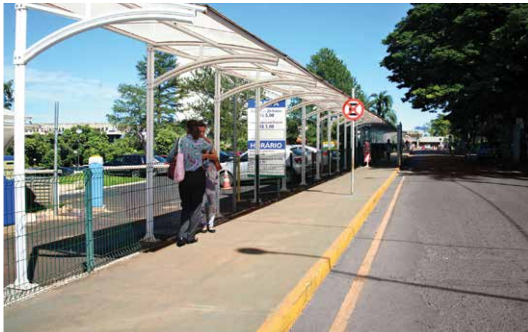
Passarela coberta na rua de acesso aos ambulatórios
