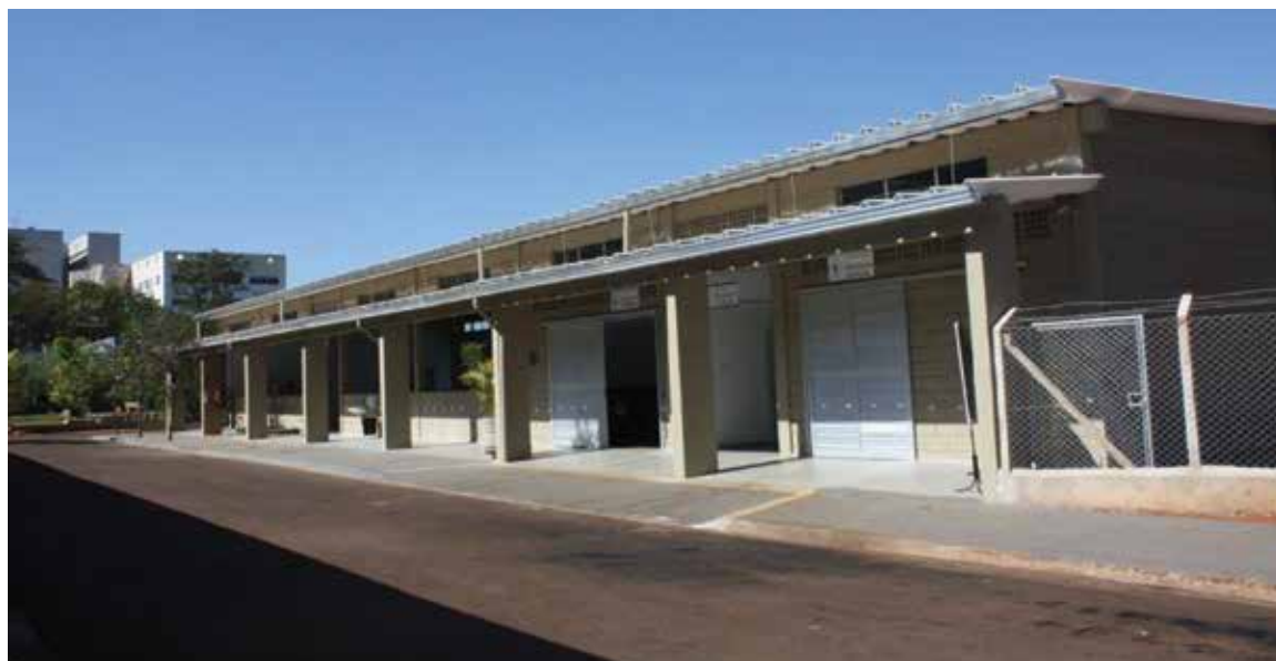
Central de Resíduos
