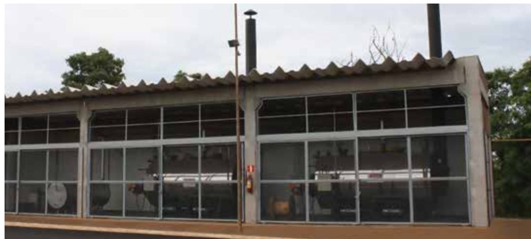
Novo abrigo para as Caldeiras a Gás
