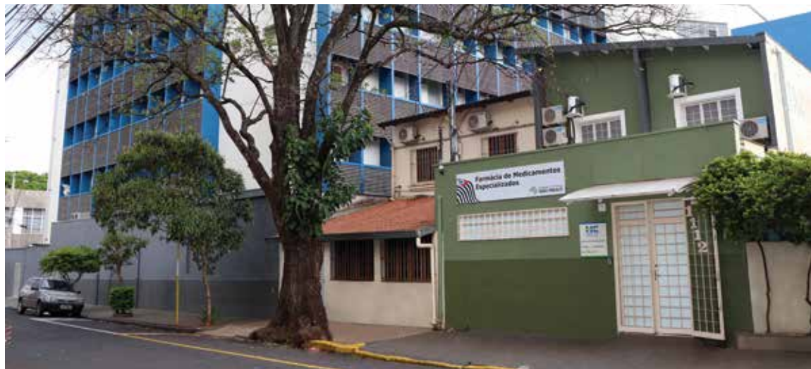
Farmácia de Alto Custo - à Rua Marechal Deodoro, anexa à U.E.
