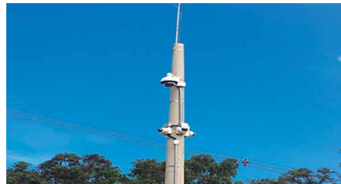
Sistema de Monitoramento - Estacionamento de Servidores
