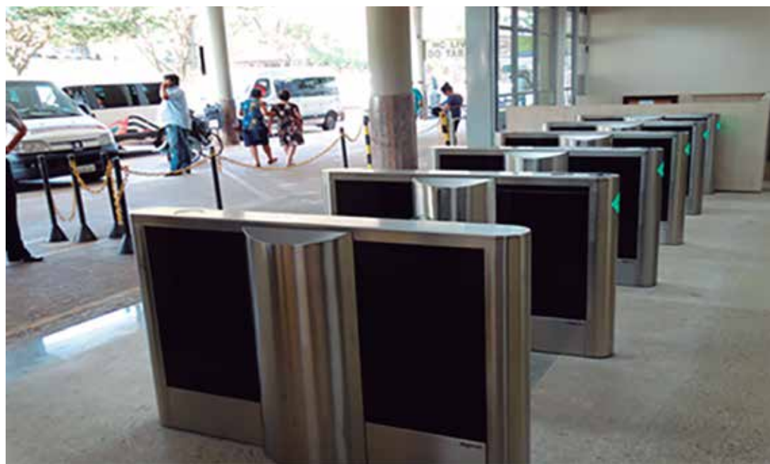
Sistema de Controle de Acesso no Ambulatório
