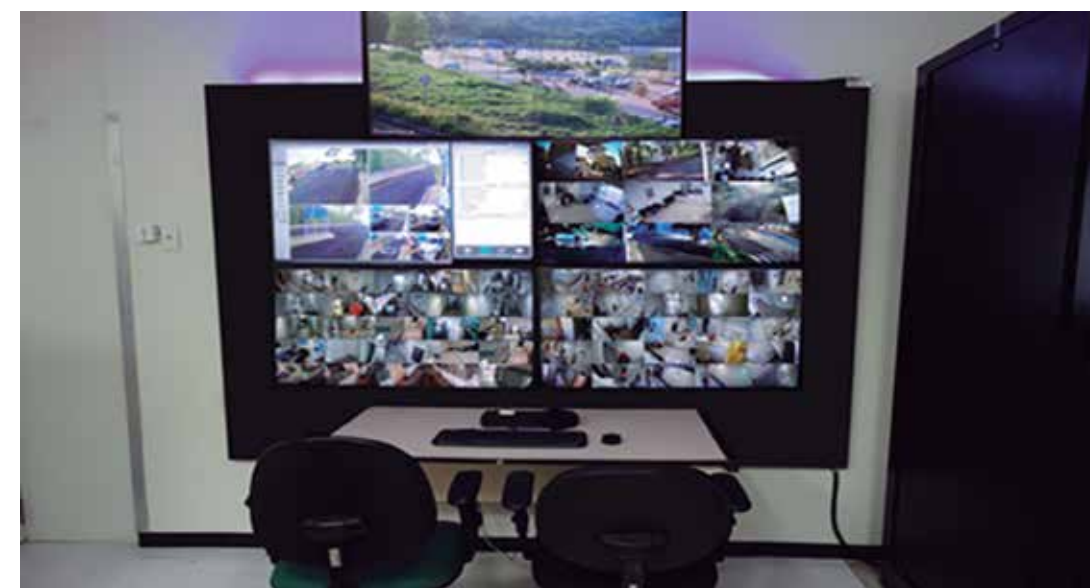
Central de Monitoramento
