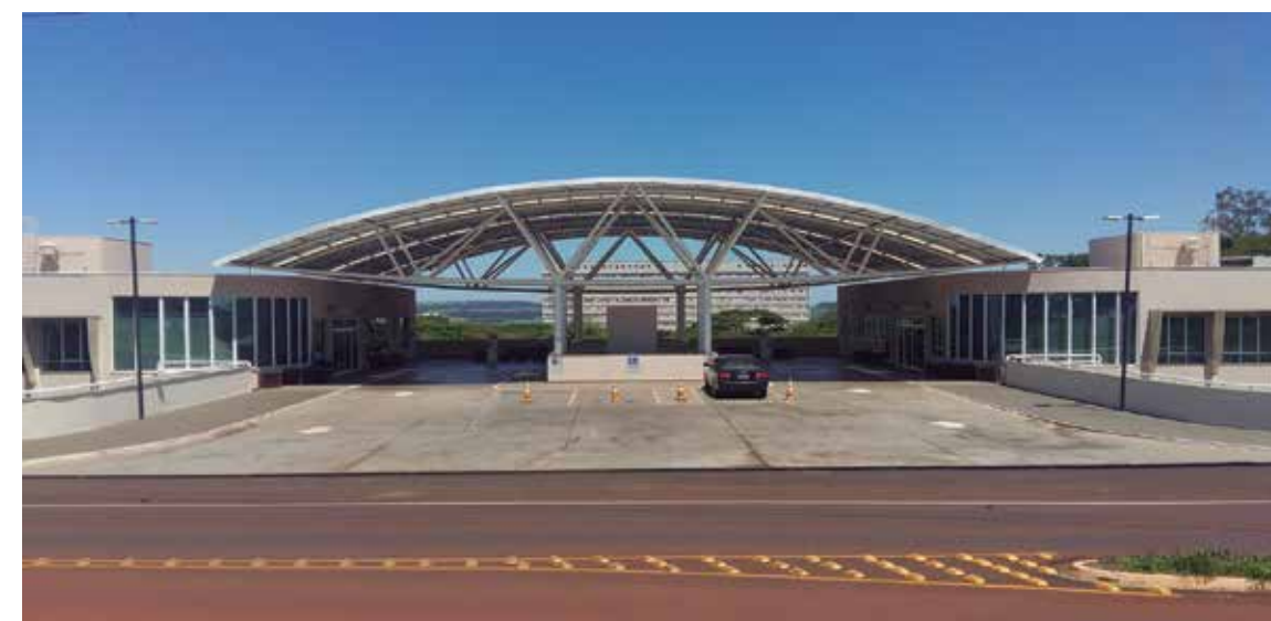
Novas instalações da área ambulatorial da Clínica Civil
