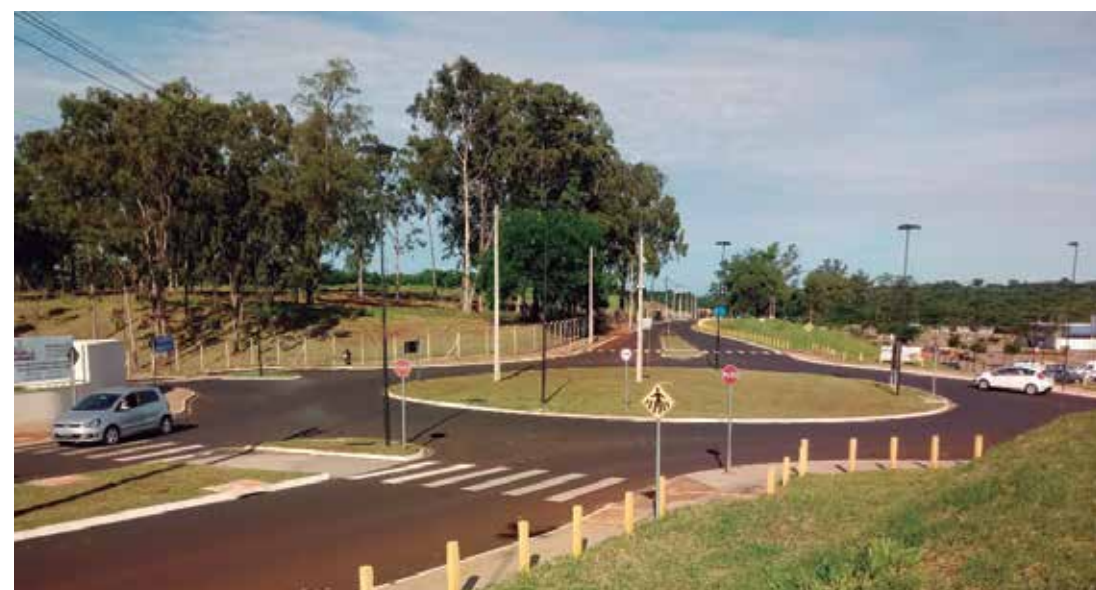
Vista parcial do Novo Sistema Viário
